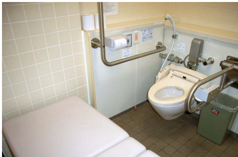
写真4 だれでもトイレ 人工肛門洗浄用の蛇口とオムツ交換用の台
