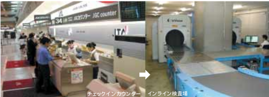
チェックインカウンター インライン検査場 インラインシステム(成田空港)
