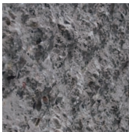
コンクリートの斫り（はつり）
