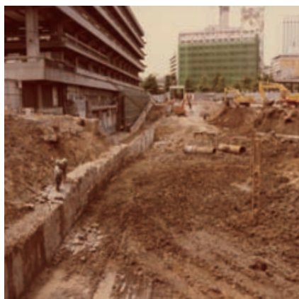
左は本館。敷地を掘り始めています。
