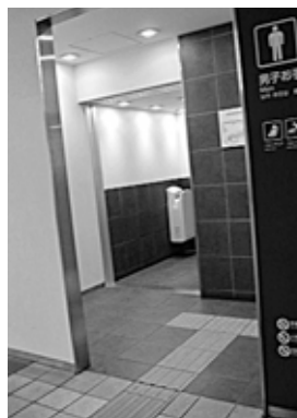
段差解消（改善後）
