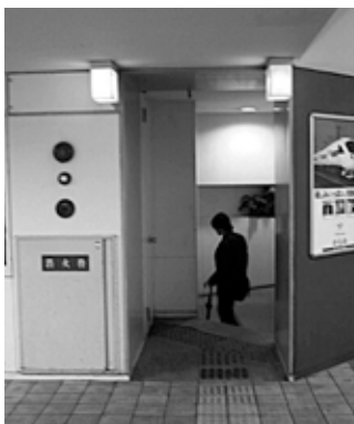
らせん階段で昇降（改善前）。多目的トイレ設置なし
