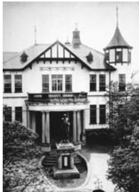
図2 麹町区富士見町(飯田橋)の通信博物館
