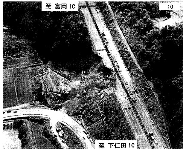
写真一1 富岡地区崩壊状況
