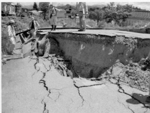
図—5.6 地すべりによる路面の被害
