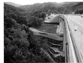
写真-4 応急対策完了状況
