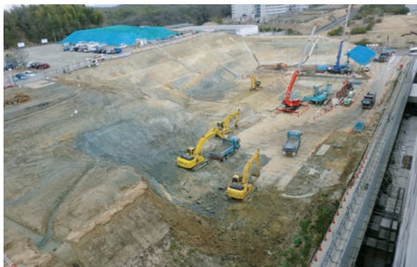
写真15 関西館第2期第1段階施設建設工事（平成29年2月）
