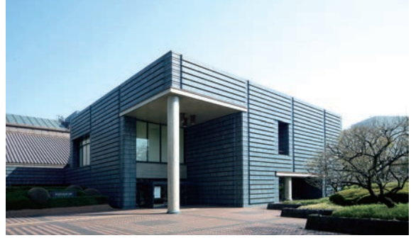
東京本館（新館）昭和 61 年開館
