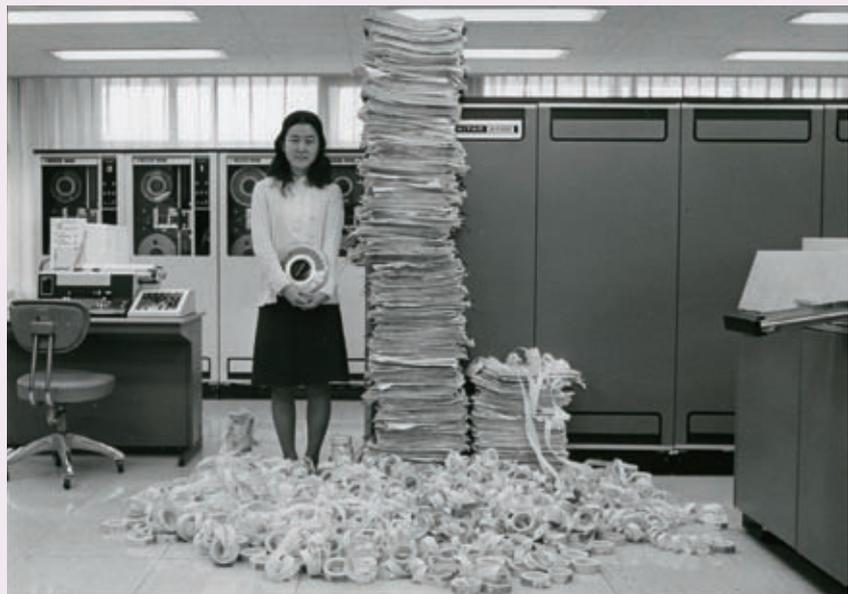
下に散らばっているのは紙テープ。初期のデータ入力は、漢字テープ穿孔機により紙テープにパンチして、テープ読み装置から入力していた。それを磁気テープ（手で持っているもの）に移す。
