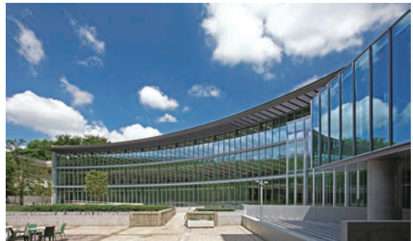
国際子ども図書館（アーチ棟） 平成 27 年開館
