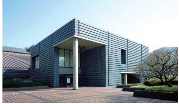
東京本館（新館） 昭和 61 年開館
