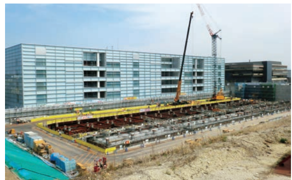
写真13 関西館第2期第1段階施設建設工事(平成30年3月)
