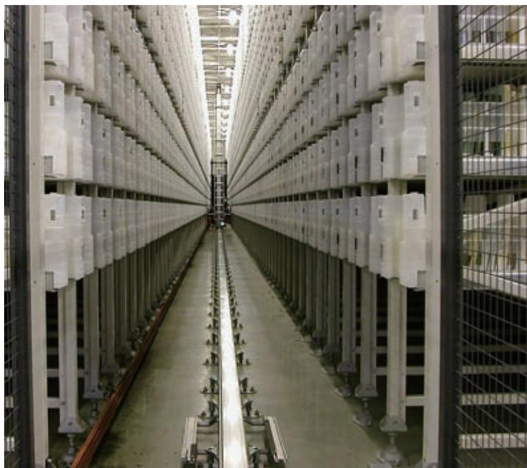
自動書庫の資料は、バーコードで1点ずつ管理されており、必要な資料が入っているコンテナをクレーンが地下3階まで運んできます。その後、資料搬送設備により、閲覧室のカウンターや事務室に運ばれます。
