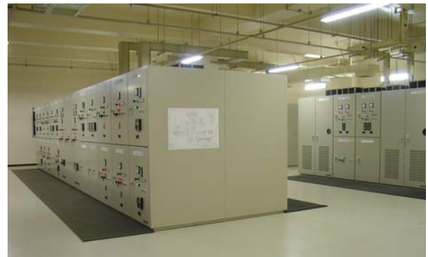
図3 第2処理施設1階受変電室
