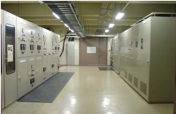
図2 本館2階受配電室
