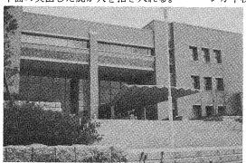
建築法規上の高さ制限があるために 3 階建て、高さは16m。図書館として必要とする22,000m²の約半分の面積は地下階にとられている。 1 階の中央から西側はすべてレファレンス室、東側は事務室。 2 階は中央がレファレンス室で、東、西側共開架閲覧室。 3 階は視聴覚施設がある図書館ホール、一般閲覧室、貴重書室など。地下は1、2階共、大半が書庫で占められ、書庫は機械室、情報処理センター及び研究個室で囲まれている。書庫を水と湿気から守るための方法として対策
