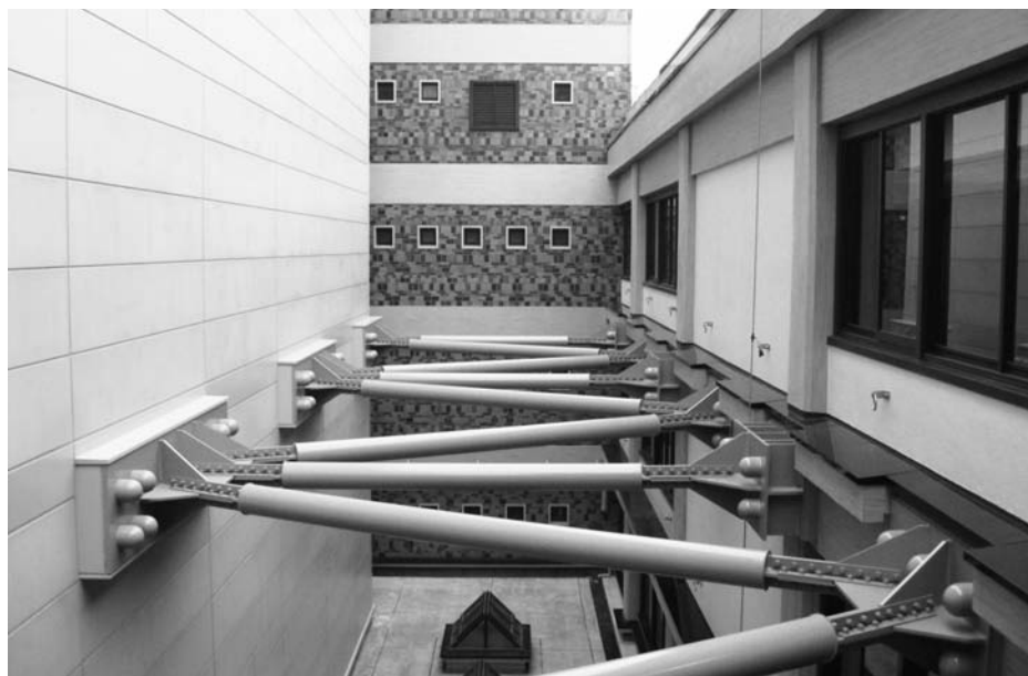
東京本館耐震改修工事
