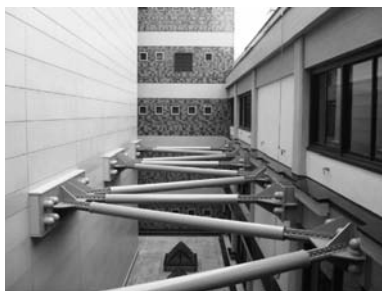
東京本館耐震改修工事
