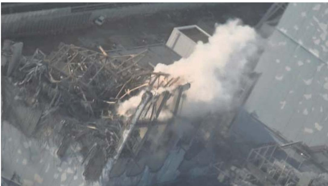
写真2.2.4-1<sup>182</sup>（水素爆発後、白煙を上げる3号機）
