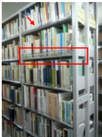
（書籍落下防止装置。1段目がバーを作動させていない状態、2段目が作動させた状態）
