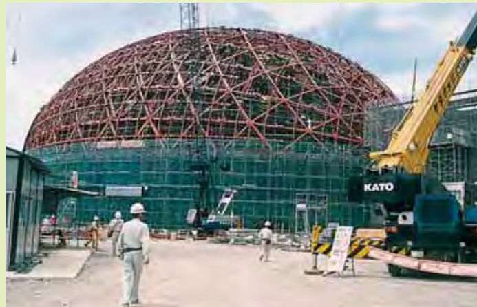
骨組みができ上がった恐竜ホール
