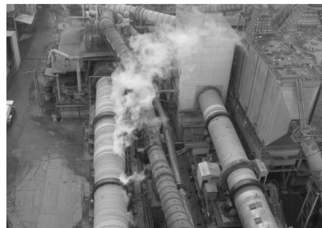
セメント焼成キルン（左側の管）とごみ資源化キルン（右側の管）
