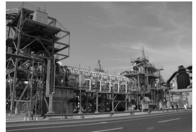
タイヤガス化リサイクル施設概観
