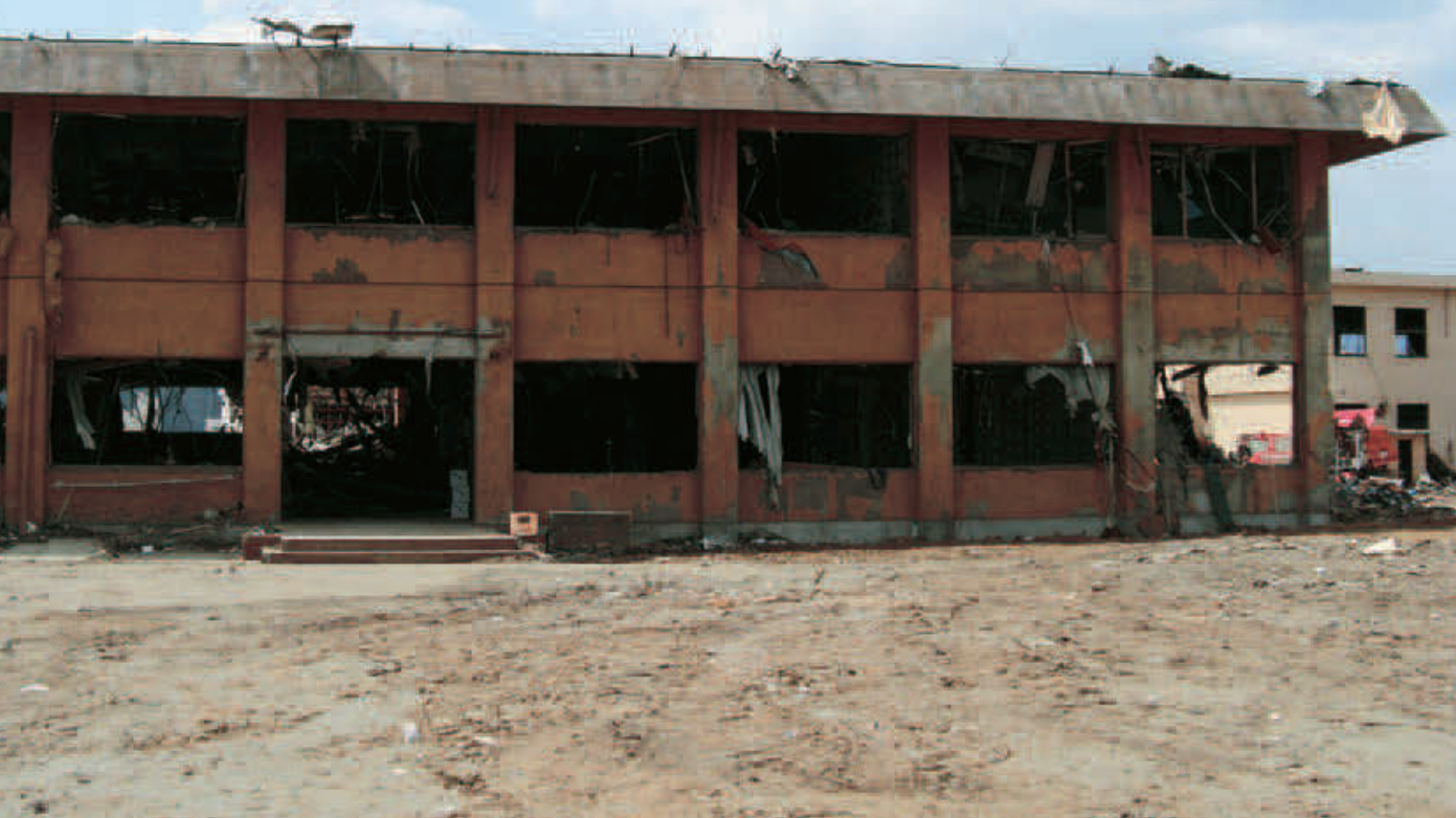
陸前高田市立図書館正面（平成23年4月12日撮影）
