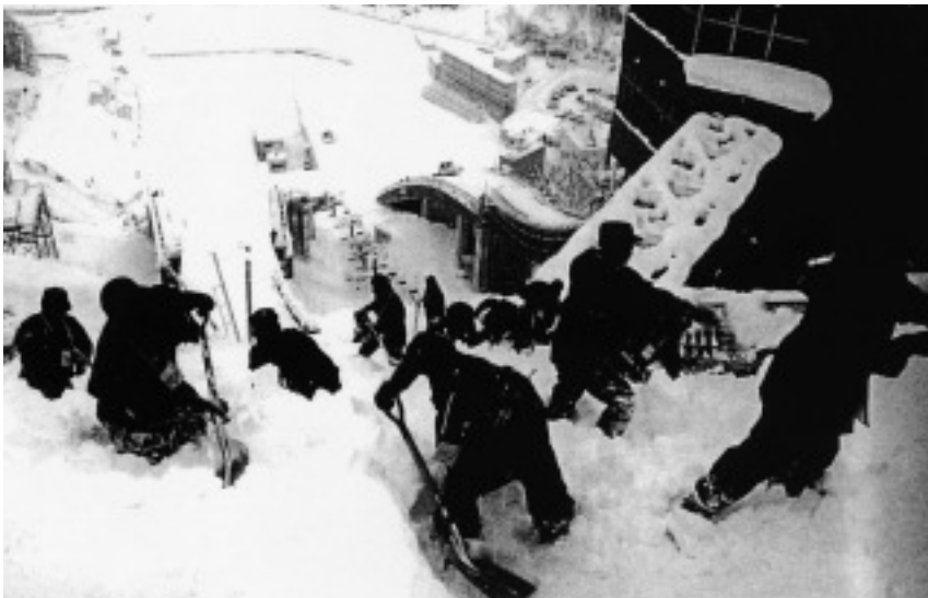
大雪の後、早朝からジャンプ台の整備にあたる第5施設群のノルディック協力隊員。高度差138mという目もくらむ高所で懸命に助走路を除雪（平成10年1月27日、長野・白馬村）
