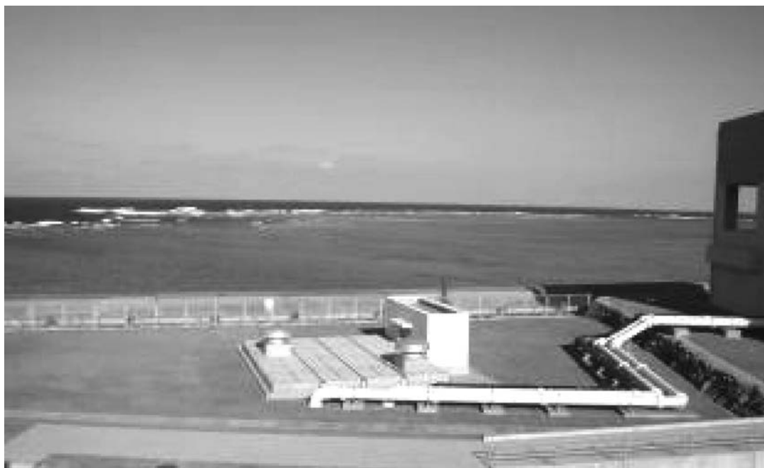
写真2 久米島の海洋深層水の取水施設
