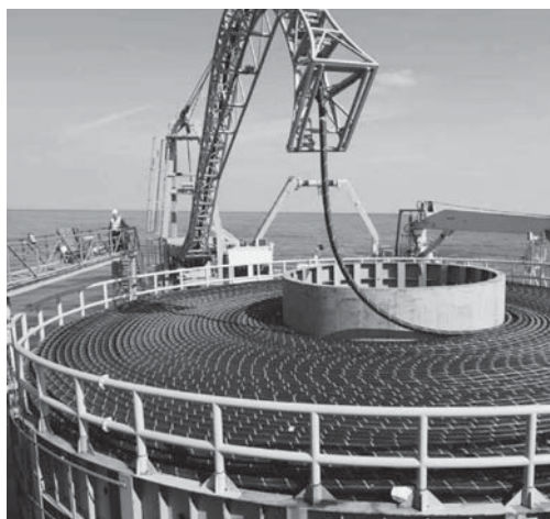
図8 海底ケーブル敷設の様子
