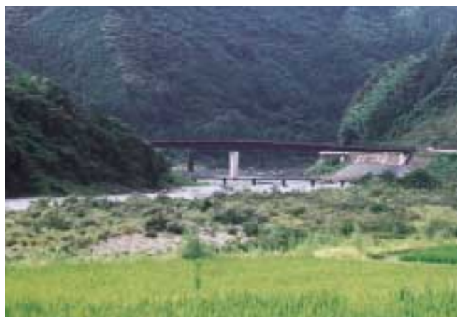
写真 - 1 潜水橋と抜水橋
