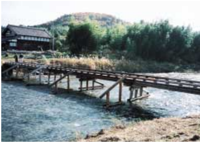
写真 - 3 久慈川水系里川の堰下橋
