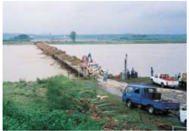
写真 - 5 荒川に架かる久下橋の被災状況
