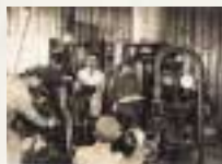
日満高等工科学校 機械工学科動力実験
