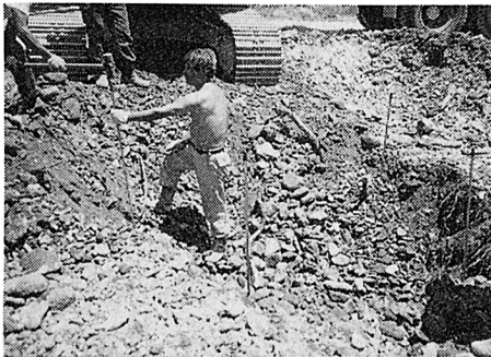
第17図 アース棒の打ち込み 打ち込めば幾らでも入る。
