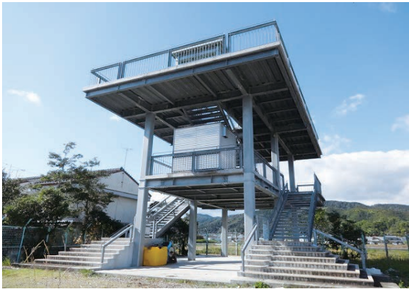
図6 万行地区の津波避難タワー
