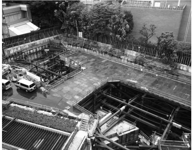
国際子ども図書館増築棟地下躯体工事
