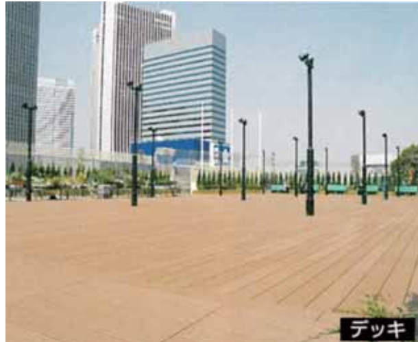
図2 WPCの施工例 【木材プラスチック再生複合材部会普及会HPより】
