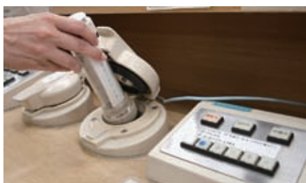
障害時には、専用のパイプ（気送管）を使って資料の申込票を書庫へ送ります
