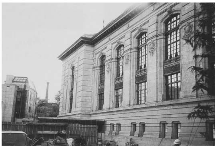
明治期改修部分の外壁工事を終え、正面前庭の整備が進む
