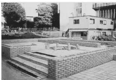
裏庭の工事風景
