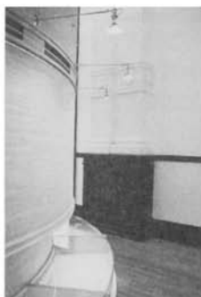
3階 本のミュージアム (改修中の様子)
