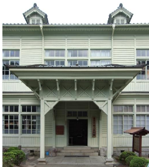
旧高梁尋常高等小学校校舎外観 岡山県に多く残る明治期建設の洋風小学校 の中でも建設年代が比較的古いもの。ステ イックスタイルの大振りな玄関が特徴。
