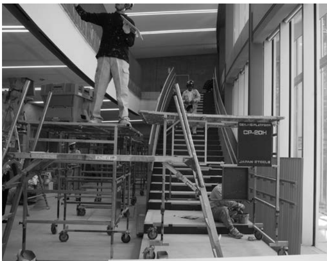
国際子ども図書館増築棟（アーチ棟）の工事
