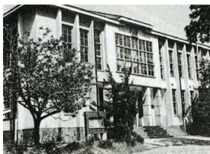
昭和24年10月 復旧竣工
