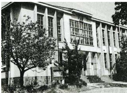
昭和24年10月 復旧竣工
