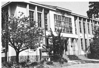
昭和24年10月 復旧竣工
