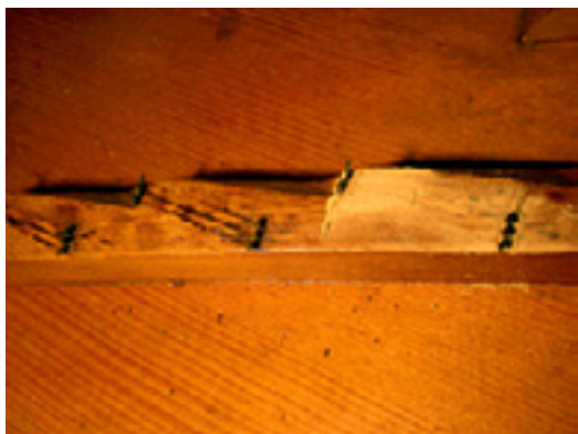
ブリッジの錆取り(右半分は作業した部分)
