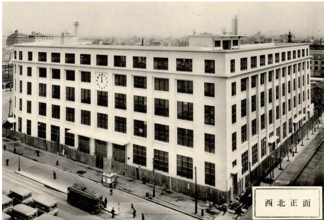
写真3 昭和6年 竣工直前の東京中央郵便局舎（大倉土木株式会社編『東京中央郵便局新築工事記念写真帖』より転載）
