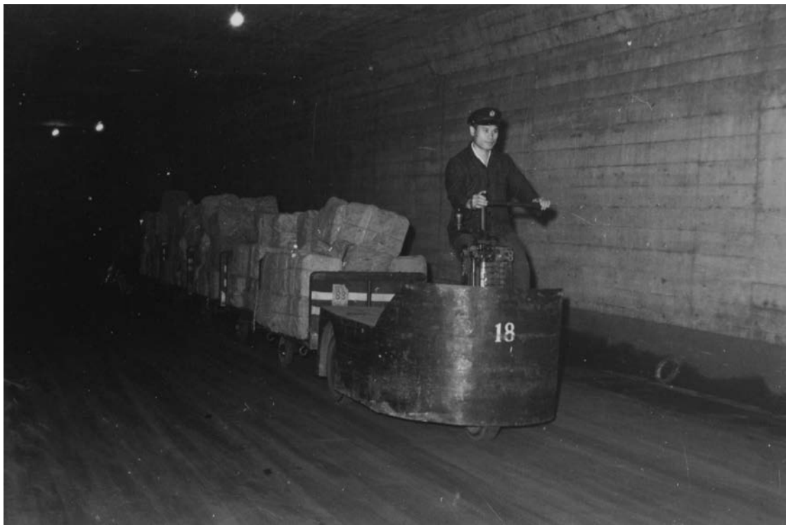
写真5 電動牽引車による郵便物搬送 昭和26年（通信総合博物館所蔵）
