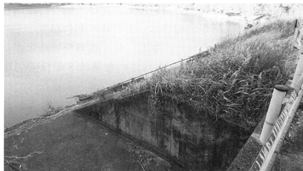
写真-5 取水口（奥）と余水吐（手前）
