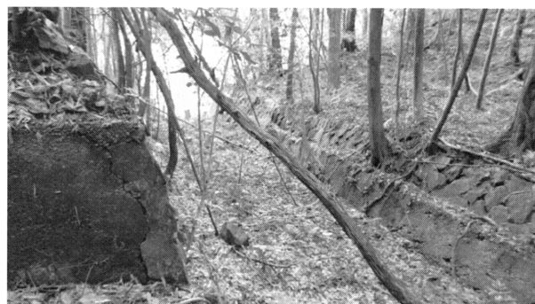
写真-6 旧水路の現状
