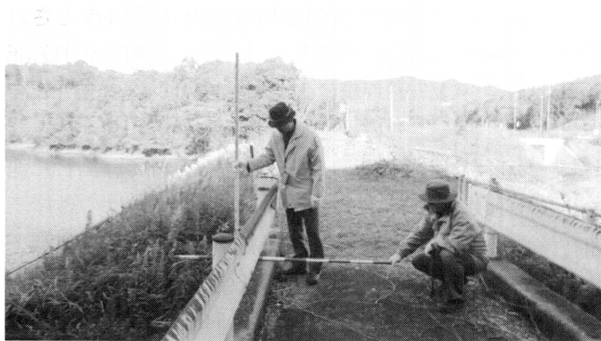
写真-4 堰堤測量の様子
