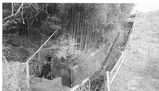
写真-7 余水吐に接続する取水路
