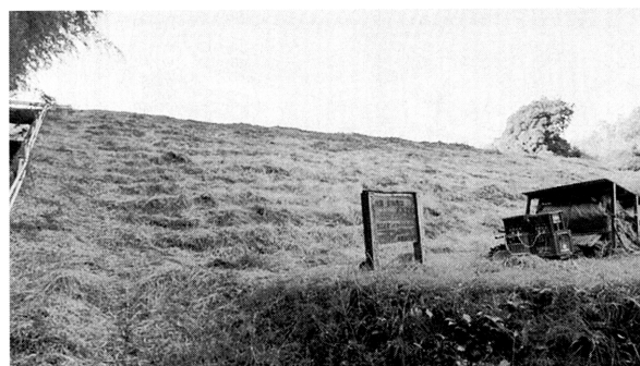
写真—3 外部から見た堰堤
