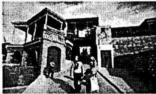
図8 カシュガル旧街区-耐震性のある新築住宅
