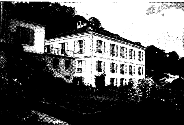
写真5 国際度量衡局管理棟(右)
