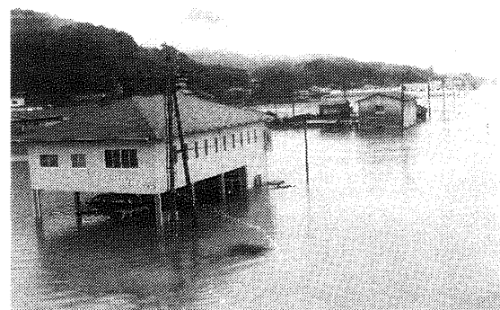
写真2 東大洲地区の洪水はんらん状況 (7月4日)
