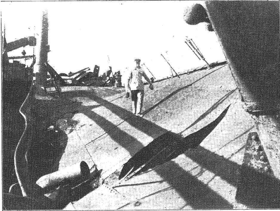
靖川丸甲板の龜裂及船口側板を示す陥落、龜裂及船口縁材の損傷
