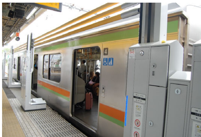
図8 拝島駅に試行導入された昇降バー式ホーム柵（バー及び支柱が上昇した状態）
