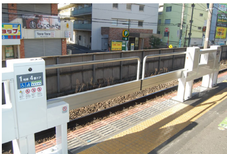
図 11 町田駅に試行導入された「スマートホームドア」
