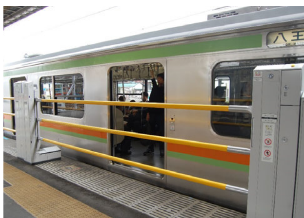
図7 拝島駅に試行導入された昇降バー式ホーム柵（バー及び支柱が下降した状態）
