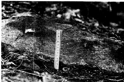
写真17. 被災地の斜面に固定している岩石の露出状態から被災後の表土の損失深度を推定できる。被災前の露出部と被災後の露出部でその色彩に明白な差異が認められる。木壳内（山根）激じん被災地。（1961.11）
