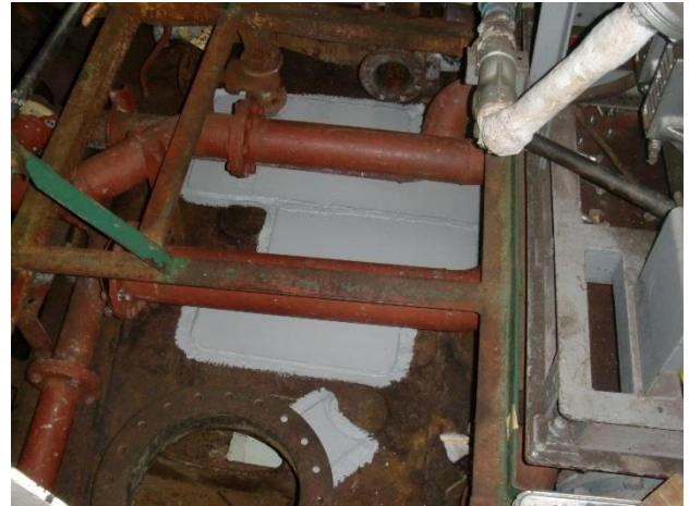
図8 タンクトップ (補強後)
