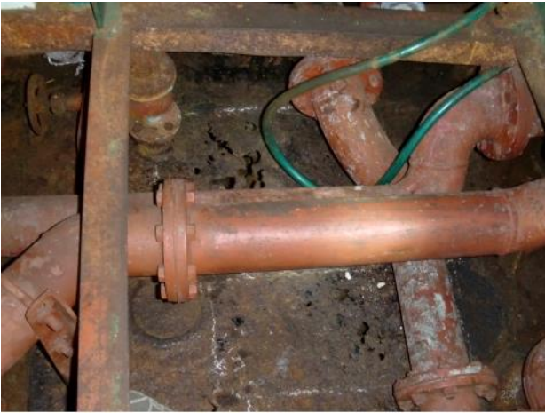
図7 タンクトップ (補強前)
