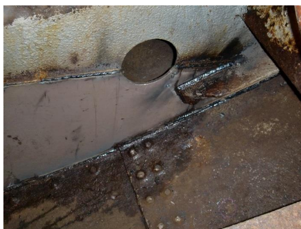
図6 機関室フレーム (補強後)
