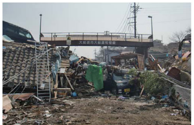
がれきで寸断された国道45号（大船渡小学校付近）
