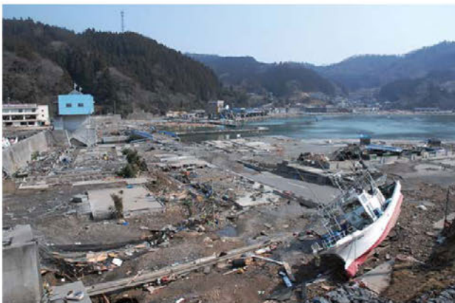
綾里漁港付近
