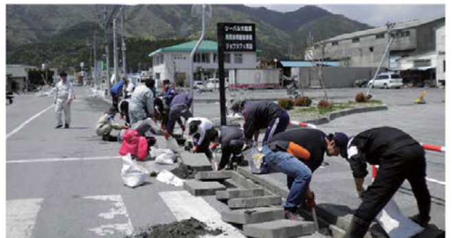
津波により溜まった側溝の泥上げ作業
