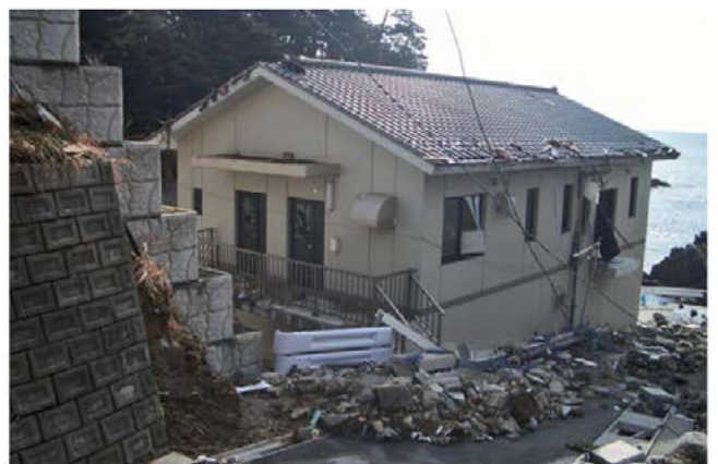
千歳地区漁業集落排水施設
