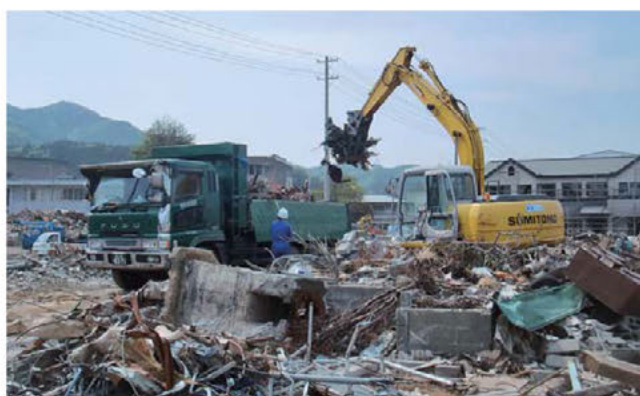
がれき撤去作業②
