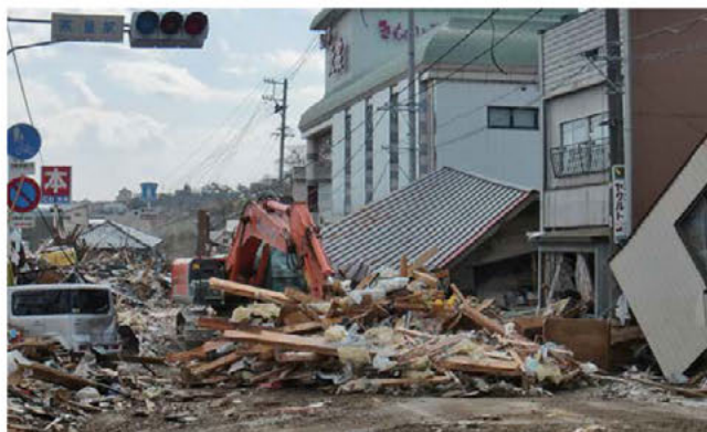
国道45号の道路啓開作業
