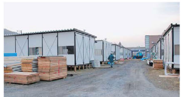
建設中の応急仮設住宅
