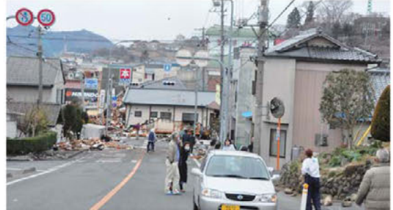
がれきで寸断された国道45号
