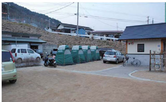
断水や下水道処理施設の被災により仮設トイレを設置
