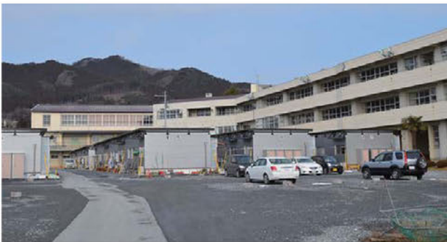
学校グラウンドにも建設された応急仮設住宅（平林応急仮設住宅）
