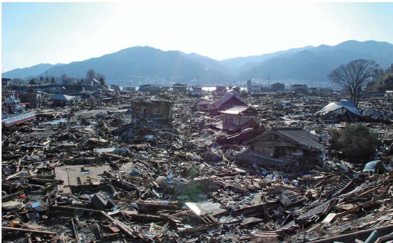
津波により一面がれきと化した生形地内
