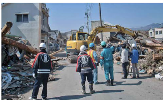
がれき撤去作業①
