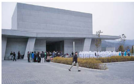
地震発生直後のリアスホールの様子（3/11）
