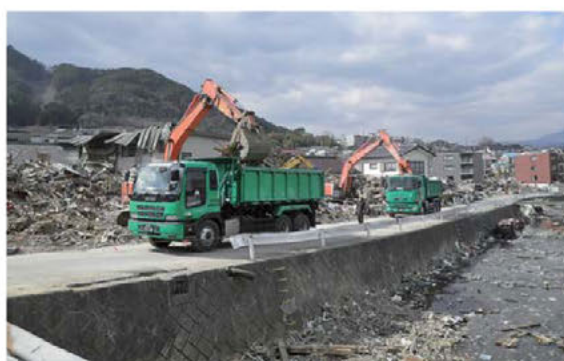
エリア分けして実施された民有地のがれき撤去
