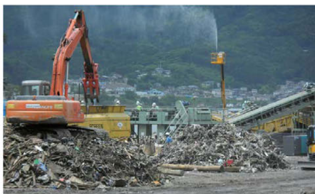
永浜・山口地区港湾埋立地に設置された二次選別所
