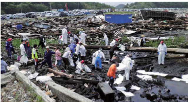
油吸着マットによる漂着した油の除去作業
