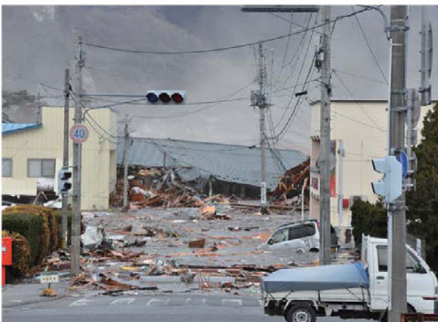
津波により建物や車両が流出（大船渡町地ノ森地内）
