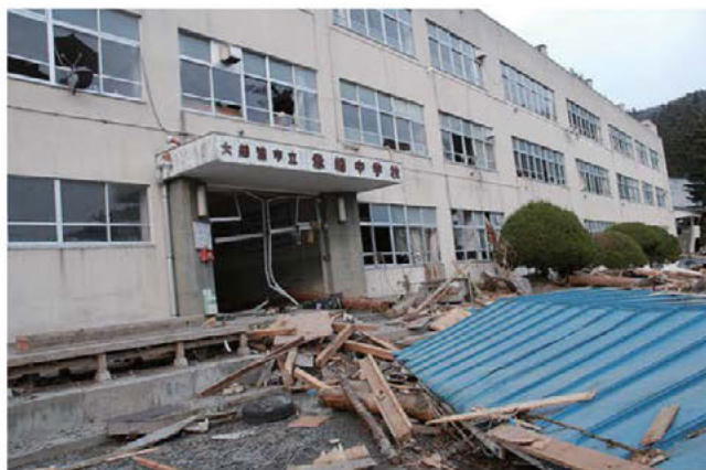
校舎が浸水した赤崎中学校
