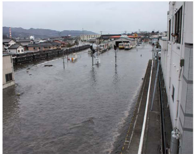
津波によりJR大船渡線・三陸鉄道南リアス線線路が浸水
