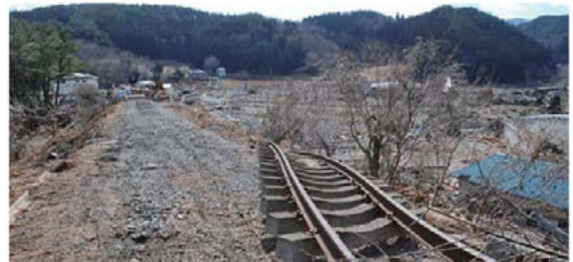
津波により流失した三陸鉄道の線路
