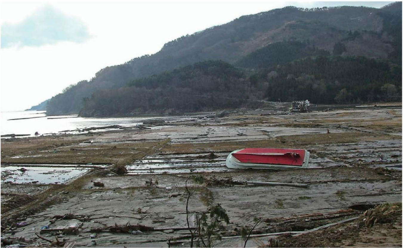
防潮堤が流失した吉浜海岸
