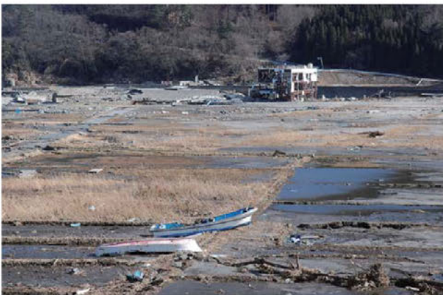
海岸付近の建物は津波で全壊（吉浜海岸）
