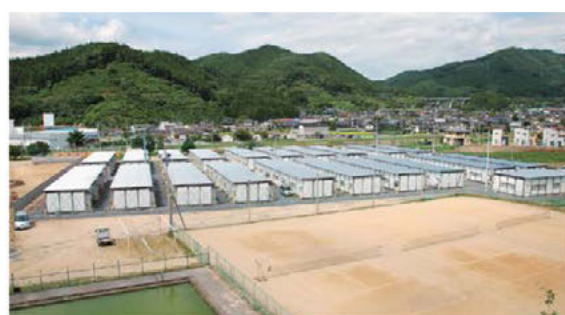
応急仮設住宅
