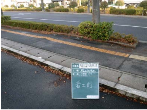
国道 431 号 ① 施工前
