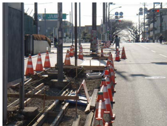
植栽基盤整備
