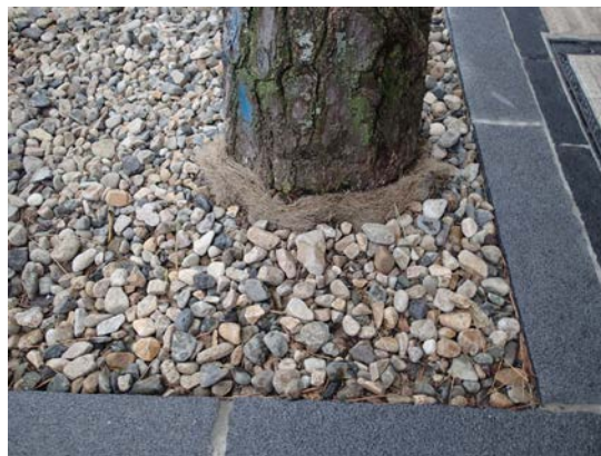
グレーチングや玉砂利による通気性・透水性の確保
