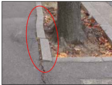
ベース付ブロックでも従来品は、横ブロック（突合せ角部）は連結ができないため、浮き上がりが生じている。
