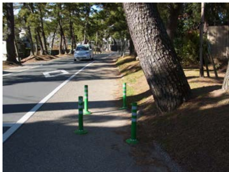
車両衝突防止用ポール
