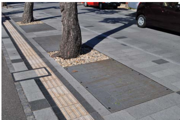
グレーチングや玉砂利による通気性・透水性の確保
