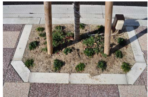
植栽基盤整備
