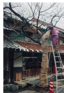
保護材の設置
