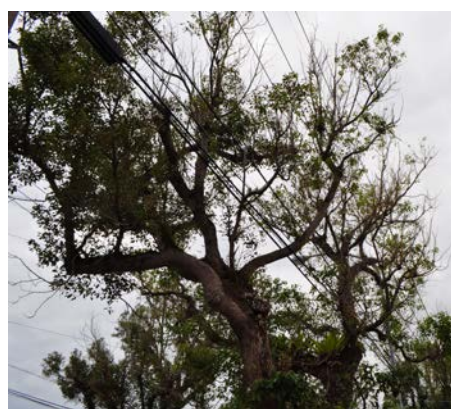
電線との競合状況
