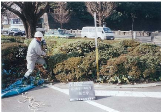
低木撤去の状況
