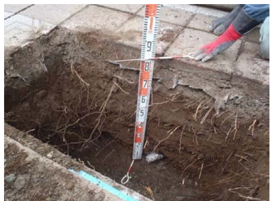
試験掘削状況
