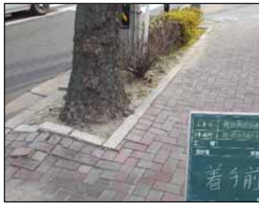
ベース付ブロックでも従来品は、横ブロック（突合せ角部）は連結ができないため、浮き上がりが生じている。
