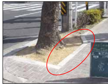
歩道幅員に余裕がある場合に、植栽帯の幅員を広げた施工例
