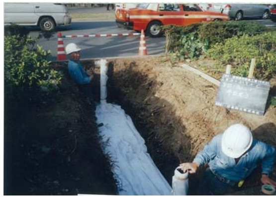
土壌改良及び通水通気管の設置状況
