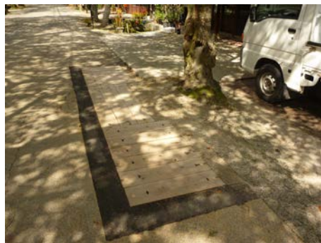
(被覆素材：鉄) 土壌改良が実施された箇所 (被覆素材：木材)
