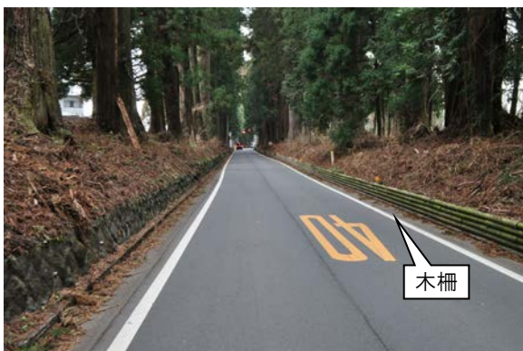
木柵設置済の状況
