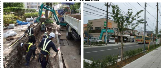
保全・再整備対策工
