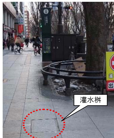
灌水柵の設置
