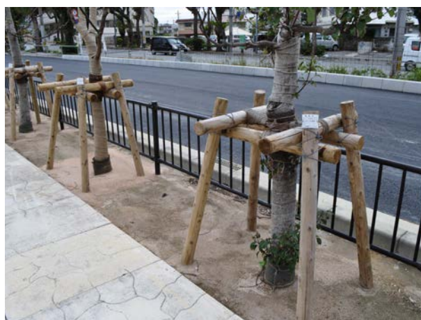
植栽基盤・支柱の状況
