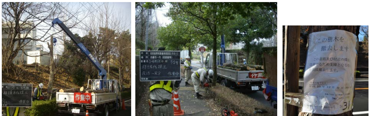
支障木の伐採状況
