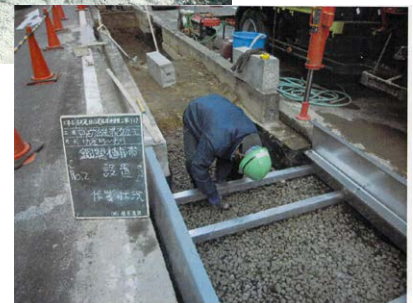
植栽樹の強化（鋼製枠） 写真提供：京都市（事例集・再整備No.11） 【根上り対策】
