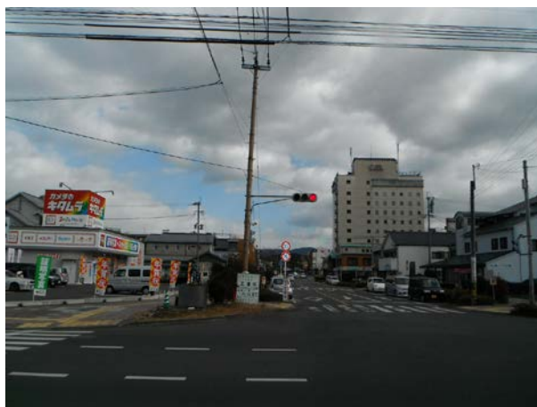
対策施工中（平成 26 年 12 月）
