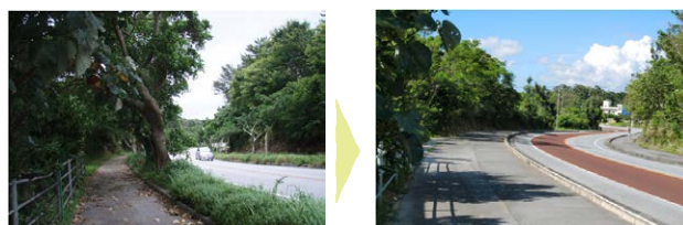
撤去・伐採後の処置
