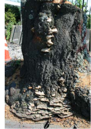
腐朽状況（ベッコウタケ）
