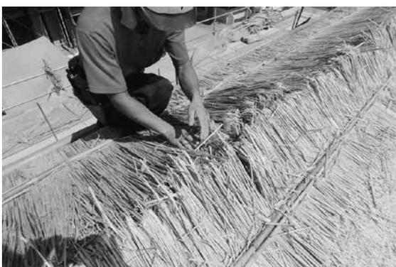
⑤ 棟の方向に茅束を敷き込んで縄で固定した。棟仕舞は、アスファルトルーフィングを100mm程度重ね合わせてかぶせ、その上に杉皮を敷いた。杉皮はまず棟方向に敷き、その上に棟と直交する方向に敷き込んだ。
