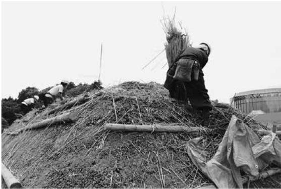
③ 棟下1m程度解体した箇所から平葺<sup>ひらぶき</sup>を行った。新規の茅を両側から厚みが均一になるように調整して重ね、押銚竹<sup>やなか</sup>と屋中竹で挟み込むようにして縄で固定した。
