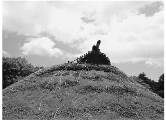
図7 茅葺屋根のずれ(中門)
