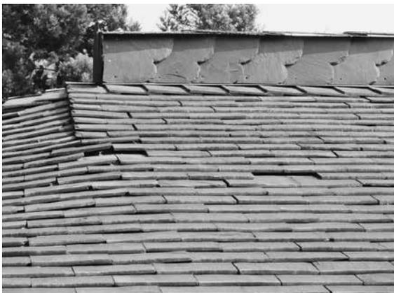
図8 屋根スレートの抜け落ち(風呂)
