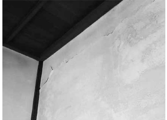
図5 漆喰壁の亀裂(母屋)
