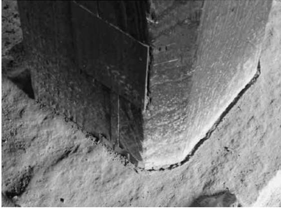
図2 柱の移動(母屋)
