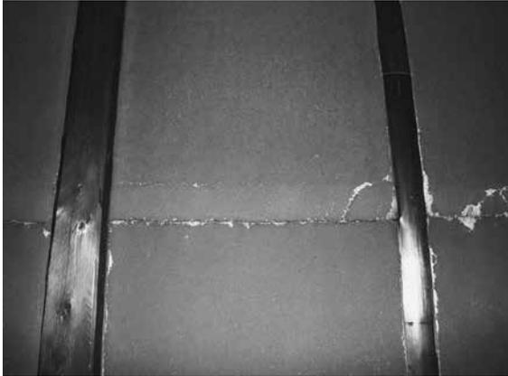
図4 貫部分の亀裂(母屋)
