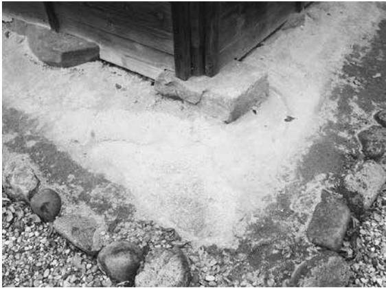
図6 モルタルの露出(母屋)
