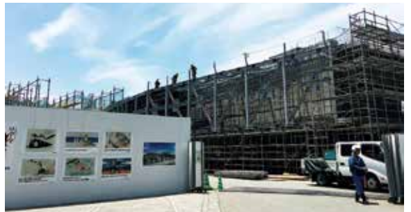
完成間近の新館
